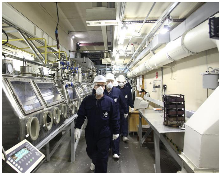
Рис 3. МОКС-производство в подгорной части ФГУП «ГХК»
